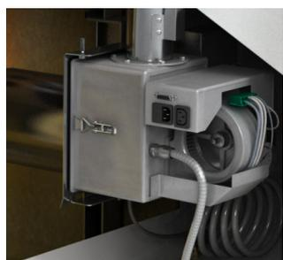
El quemador de la caldera se limpia automáticamente con aire comprimido. De manera sencilla se puede fijar el intervalo de limpieza en función de la calidad del pellet.
